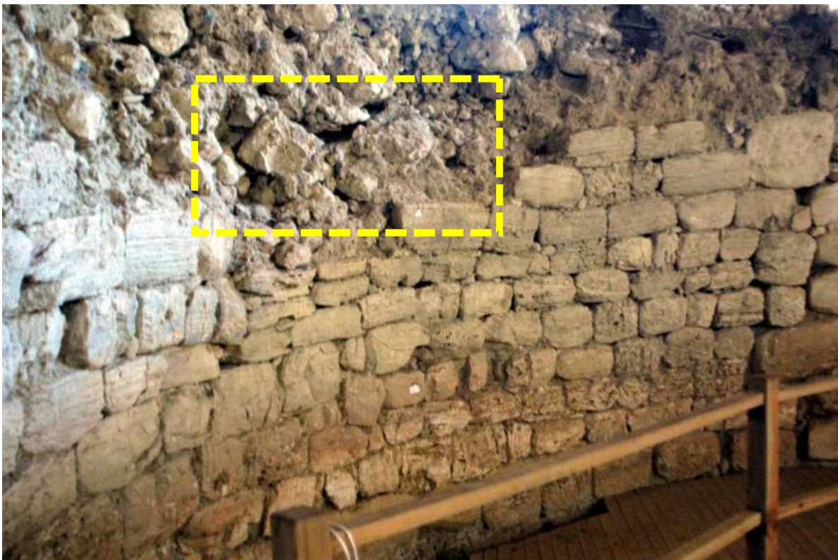
Εικόνα 4-6: Θέση δειγματοληψίας υλικού
