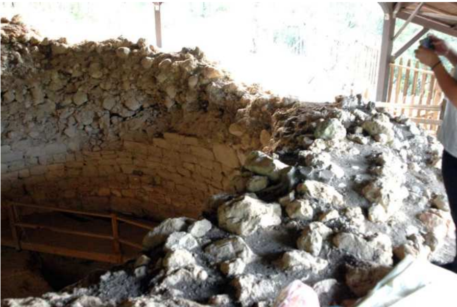
Εικόνα 2-6: Υλικά πλήρωσης ορύγματος τα οποία, ελλείψει των ανώτερων θολοσειρών, ολισθαίνουν προς το εσωτερικό.
