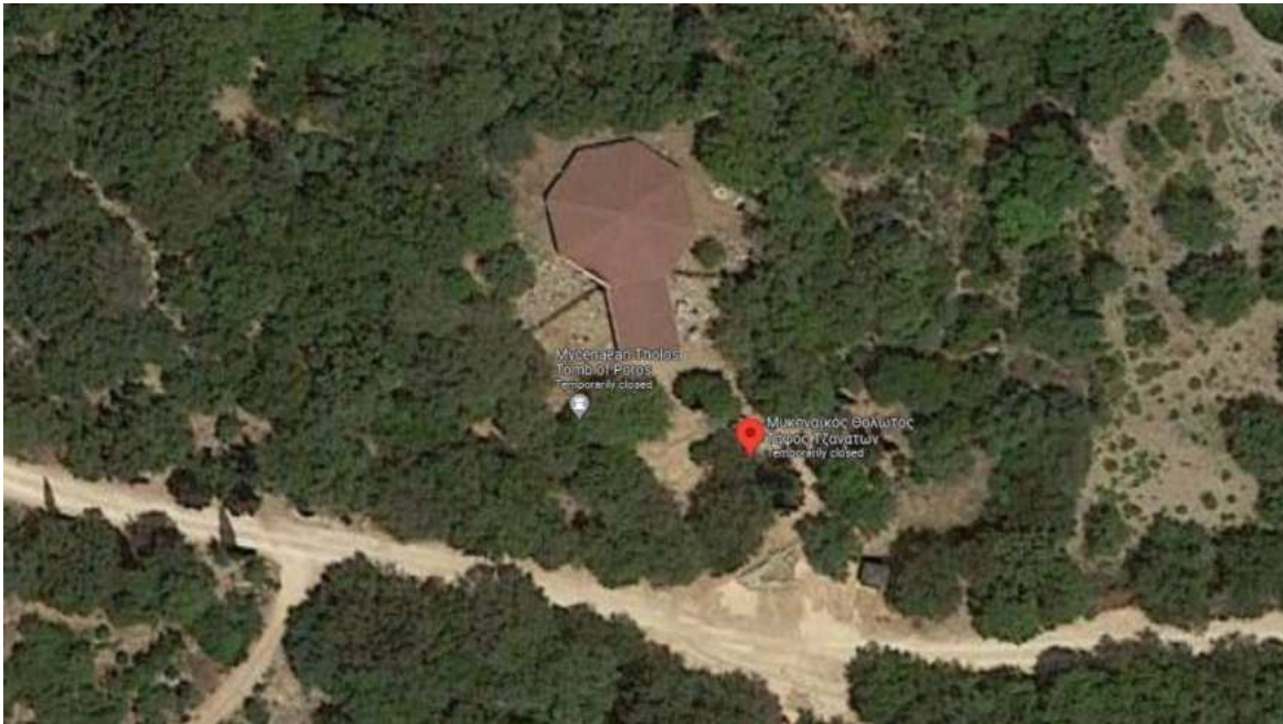
Εικόνα 1-11: Αεροφωτογραφία (πηγή google maps). Αγροτική οδός που οδηγεί στον Αρχαιολογικό χώρο – ξύλινο στέγαστρο προστασίας ταφικού μνημείου
